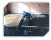
Le béton d'argile permet la réalisation de dalles de 10 cm d'épaisseur et la réalisation d'un béton ciré écologique.
